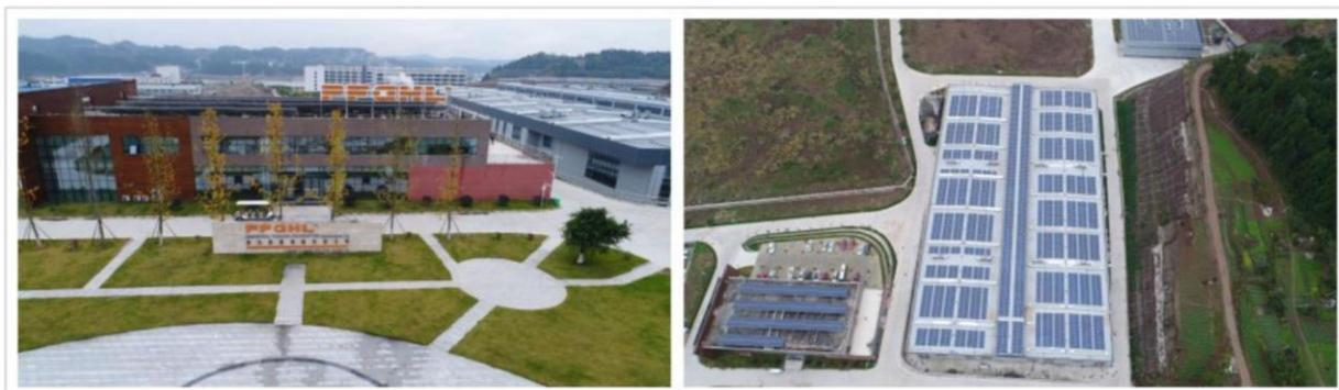
光伏发电站安装在家丰时装厂的生产车间、仓库和办公大楼，总计装机容量为 1022.08KWP。该项目采用自发自用余电上网模式，剩余上网卖给国家电网，可实现年均发电度数约 100 万度。
